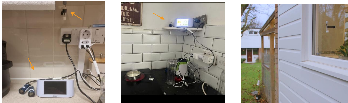
FIGURA 4. UBICACIONES HABITUALES DE LOS SENSORES DE NO 2 Y CO, SENSOR DE PM 2.5 /CO 2 Y SENSORES PASIVOS DE NO 2
